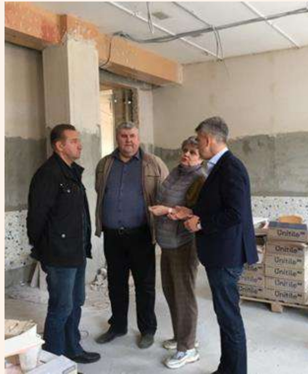
Мониторинг проведения ремонтных работ в МАОУ «Гимназия № 25»
