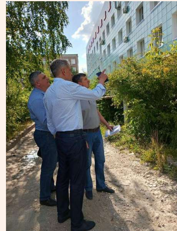
Проверка хода работ по капитальному ремонту Поликлиники №30
