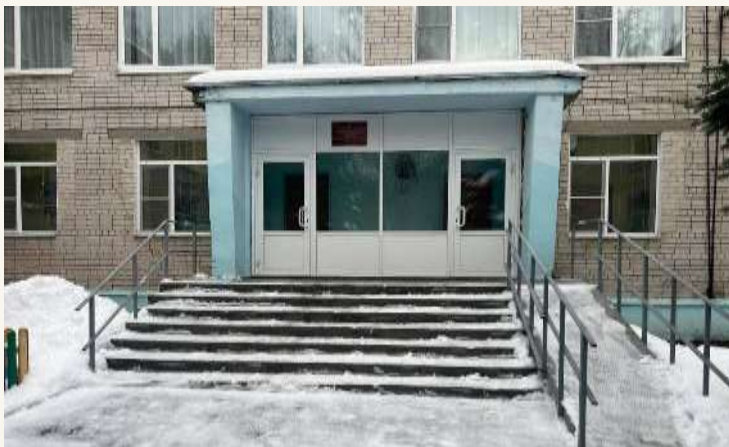
МБДОУ «Детский сад № 49 «Светлячок» - ремонт крыльца центрального входа
