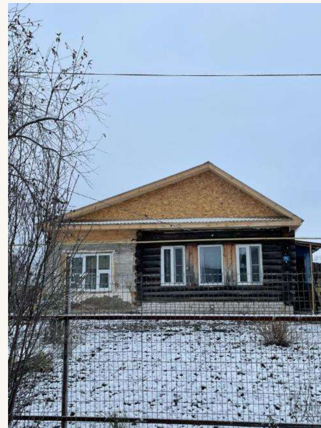
Ремонт крыши дома в д. Князевка
