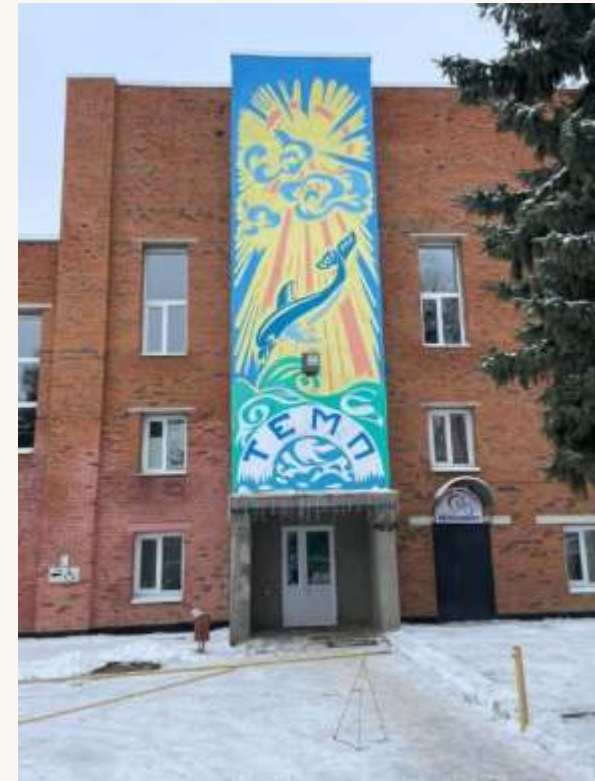
Реставрация панно на здании бассейна «Темп»
