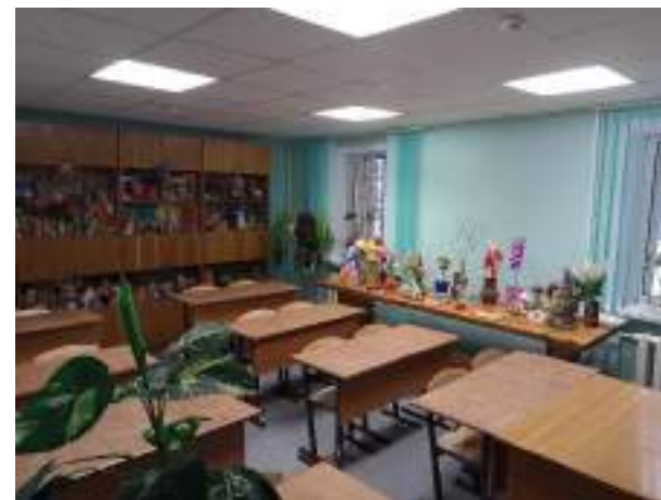
В детском клубе «Россиянка» выполнен ремонт помещений
