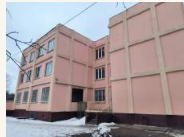
В школе №190 отремонтированы русты здания и покрашен фасад
