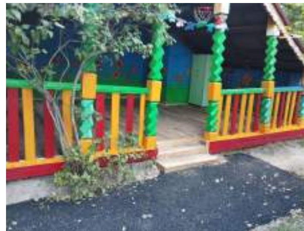
В МБДОУ «Детский сад №121» отремонтирован пол веранды
